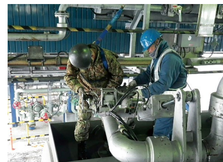
自衛隊員（左）と当社油槽所員による燃料積込訓練
