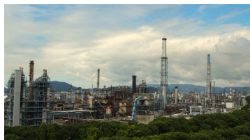
常圧蒸留装置撤去後の旧・徳山製油所
