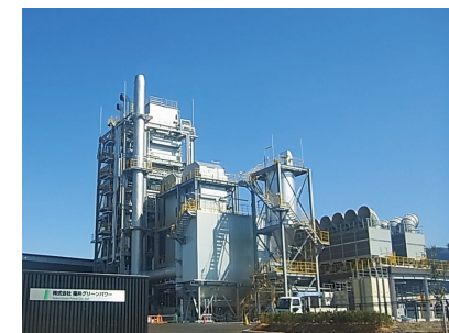
（株）福井グリーンパワー・大野発電所
