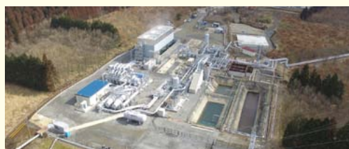
出光大分地熱(株)滝上事業所パイナリー発電所
