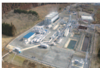
滝上バイナリー発電所の全景
