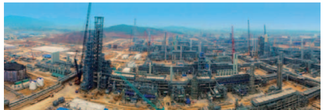
ニソン製油所・石油化学コンプレックスの精製・製造装置の建設現場
