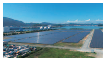
門司発電所（メガソーラー）
