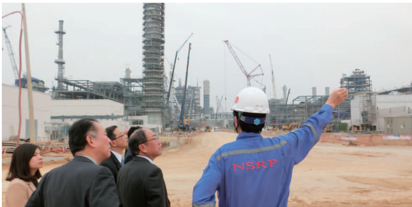
ベトナムのニソン製油所・石油化学コンプレックスの建設現場を視察
