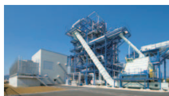
土佐グリーンパワー（株）土佐発電所
