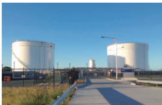
フリーダムフューエルズ社が長期リースする石油貯蔵タンク（ブリスベン港）
