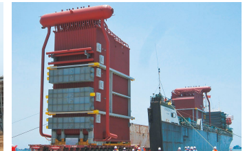
ボイラーの荷揚げ
