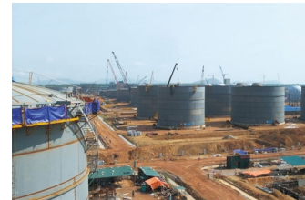
製品タンクの建設
