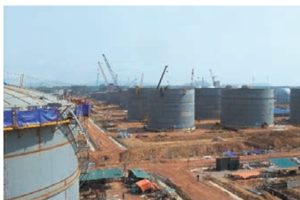
製品タンクの建設
