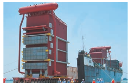
ボイラーの荷揚げ
