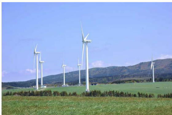
六ヶ所村二又風力発電所(画像提供:二又風力開発(株))
