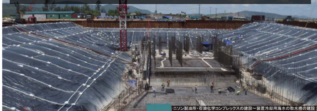
ニソン製油所・石油化学コンプレックスの建設～装置冷却用海水の取水槽の建設
