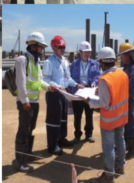
建設現場にて
