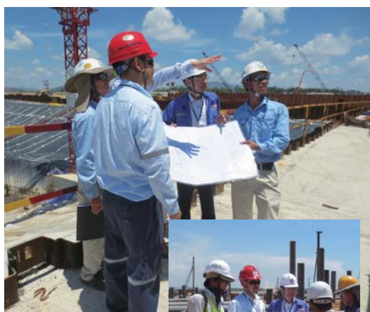
重油流動接触分解装置建設のための杭打ち
