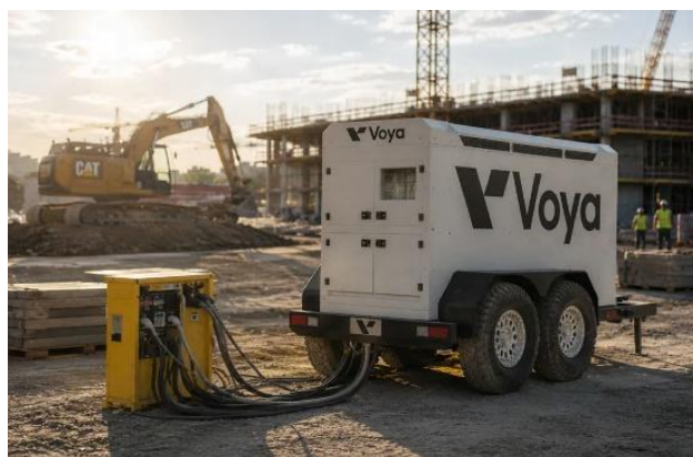
建設現場に設置された Voya 発電機のイメージ
