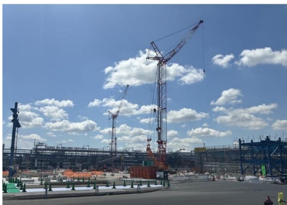
建設中の大型パイロット装置
