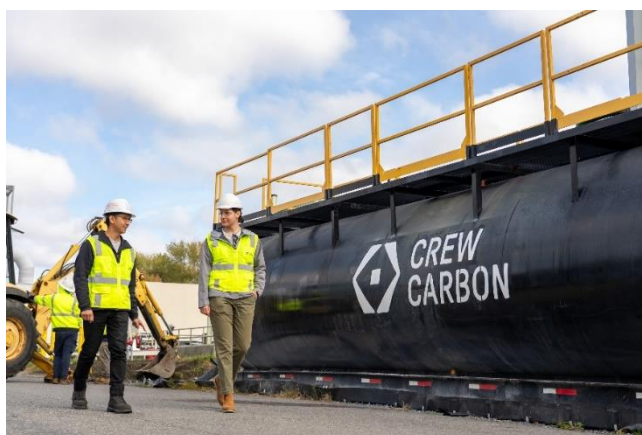
CREW 社の CDR 関連設備
