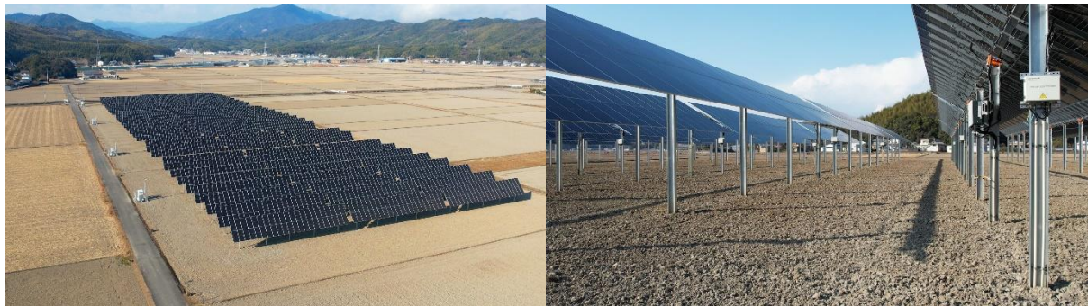
出光徳島営農型太陽光発電所
