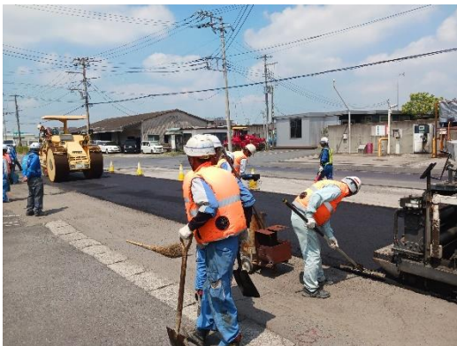
舗装施工状況
