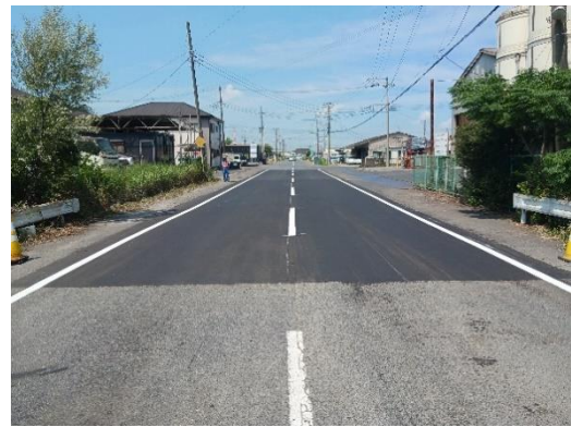
舗装施工完成状況
