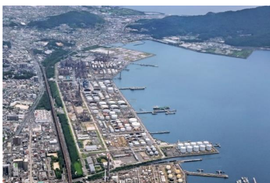
HEFA-SAF 製造設備の建設予定地である徳山事業所（写真中央）
