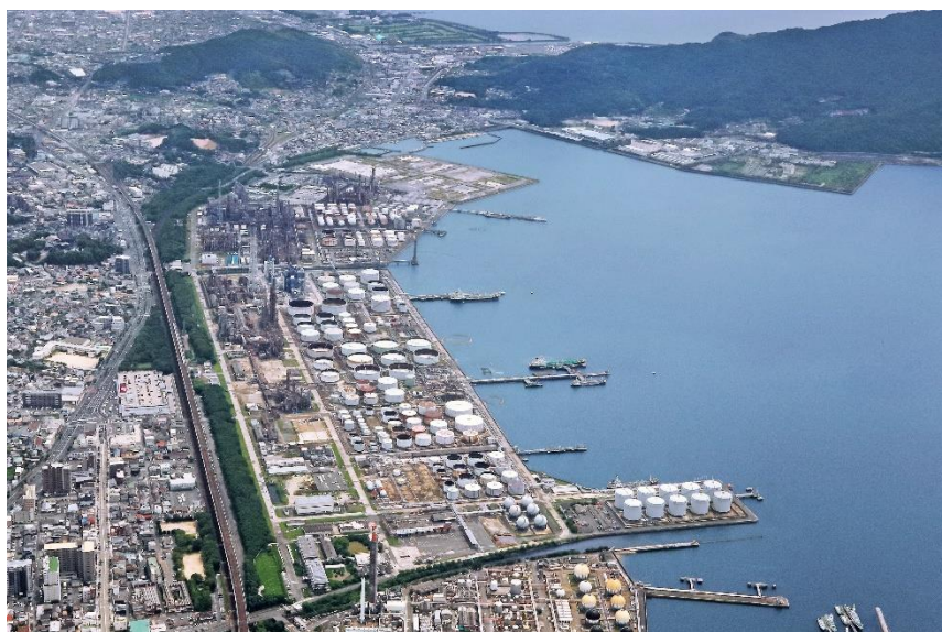
HEFA-SAF 製造設備の建設予定地である徳山事業所（写真中央）
