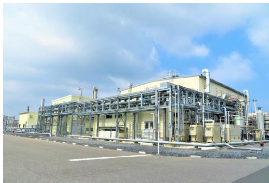
[能力増強予定の第1プラント]
