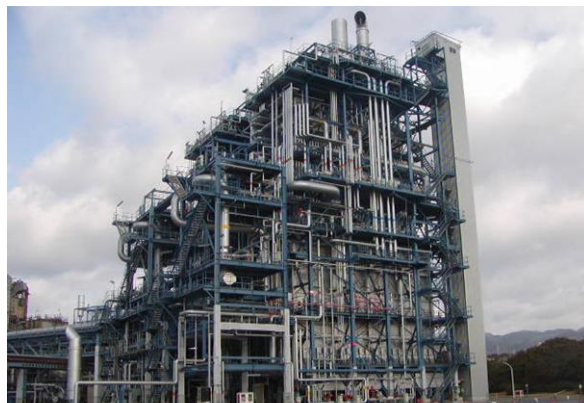
建設予定の分解炉と同型の高効率ナフサ分解炉
