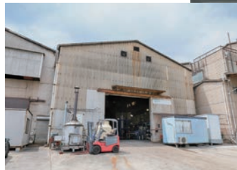
実証プラントの外観
