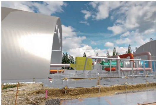
国立・国定公園内の建築物の高さは原則13m以下に制限されている。高さを必要とする天井クレーンを使わずにメンテナンスができるよう、可動式ドーム型建屋を採用している（イメージCG）
