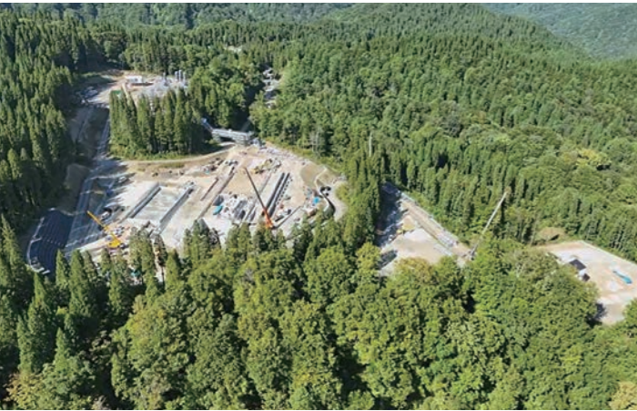
遠方からの景観に配慮して、敷地外周のスキを伐採せずに残置した
