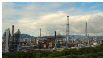
常圧蒸留装置撤去後の旧・徳山製油所
