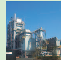
(株)福井グリーンパワー 大野発電所
