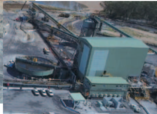
選炭設備で不純物を分離して石炭の品質を向上
