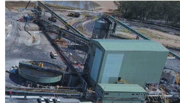
選炭設備で不純物を分離して石炭の品質を向上
