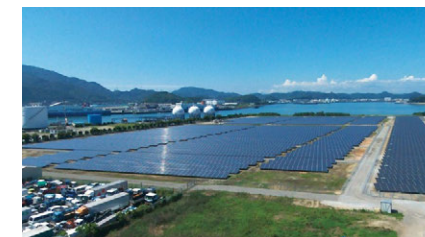
門司発電所（メガソーラー）
