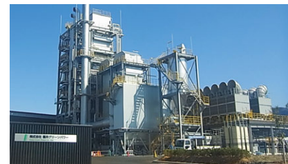
（株）福井グリーンパワー・大野発電所
