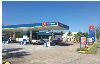
フリーダムフューエルズ社運営のSS (Capalaba)
