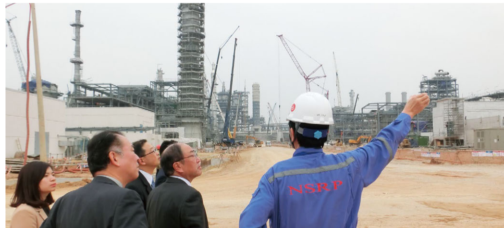
ベトナムのニソン製油所・石油化学コンプレックスの建設現場を視察
